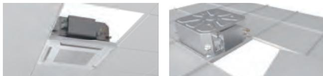
La rejilla de entrada de aire se puede instalar en varias direcciones, así que el mantenimiento es fácil.
